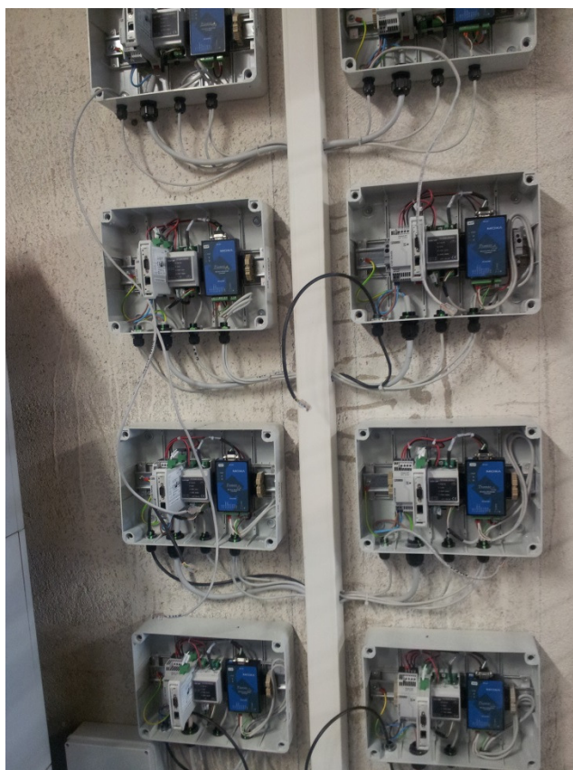
Figura 11. Concentratori installati presso alcuni UA con inverter.
