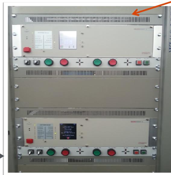
Protezione integrata di trasformatore. Telaio unificato per coppia di trasformatori.
